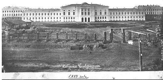
Томский (Сибирский) университет в последней стадии строительства, 1884
