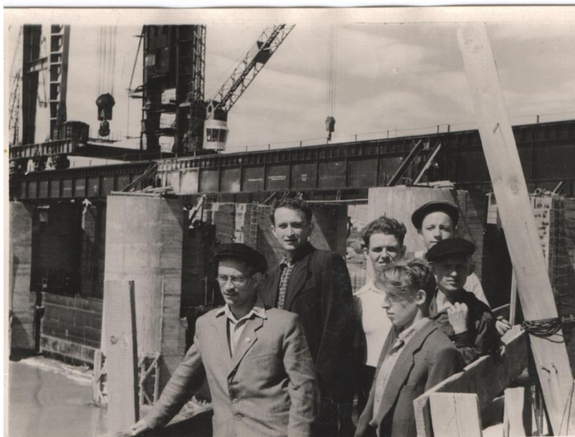
Студенты - энергетики на экскурсии строительства Новосибирской ГЭС.
