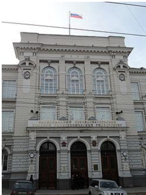
Главный корпус ТПУ
