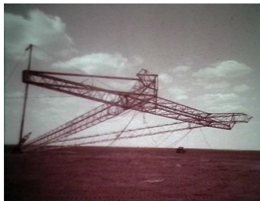
Подъем опоры ПОГ-1150 методом падающей стрелы в полевых условиях.
