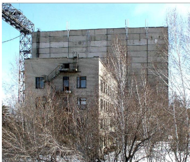
Лабораторный 4-х этажный корпус, пристроенный к высоковольтному корпусу ВИКа СибНИИЭ
